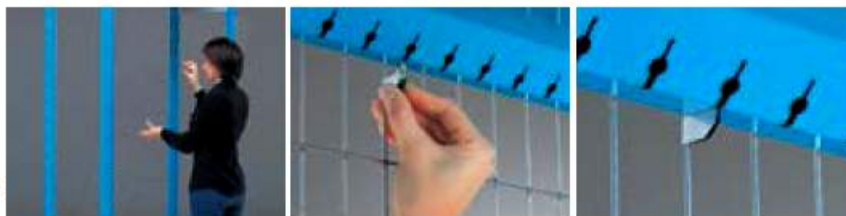
Montaggio della rete
